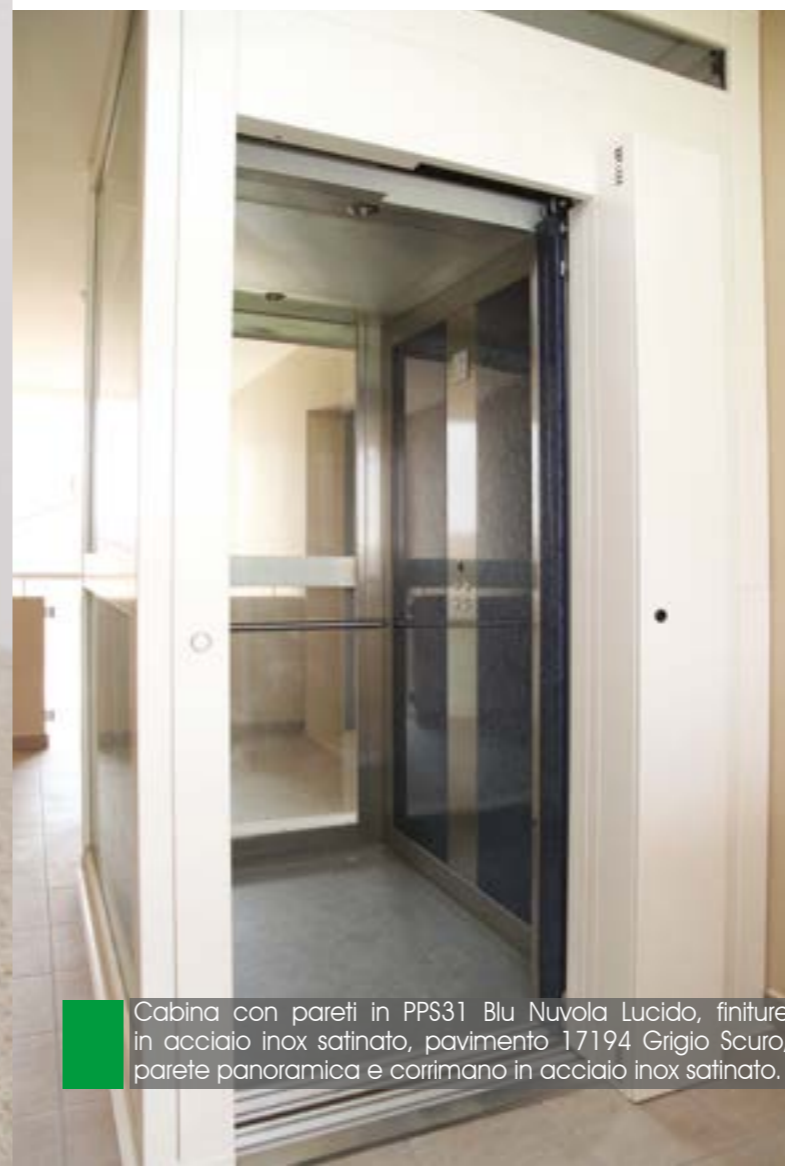
Mangusta con vano in struttura metallica rivestita in acciaio inox satinato con tamponamento "Vetro Puntuale" extrachiaro. Porte di cabina e di piano automatiche versione "Total Glass". Cabina con pareti panoramiche e finiture in acciaio inox satinato.
