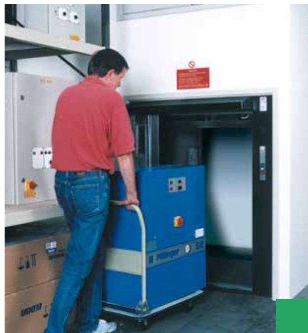
Installazione in un magazzino (Inghilterra), modello 200 kg. Anche le apparecchiature più grandi possono essere trasportate senza problemi.
